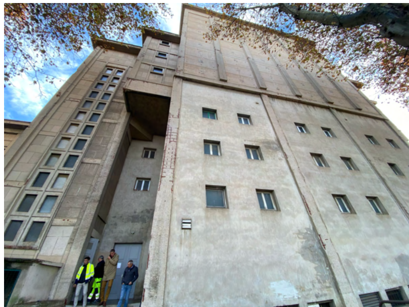
Bloc central du bâtiment depuis la façade Nord
