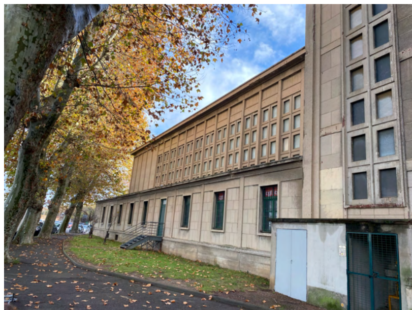
Aile Est depuis la façade Nord
