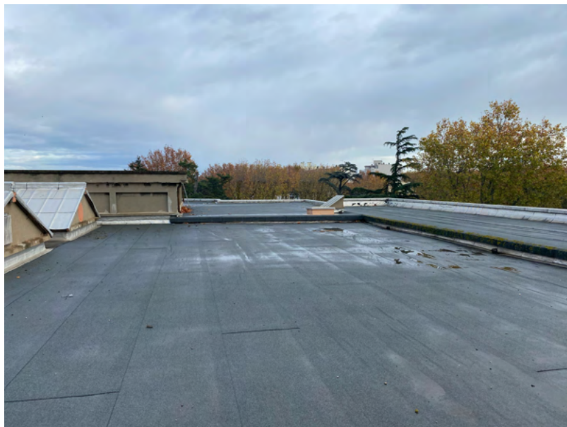
Étanchéité autoprotégée sur la toiture de l'aile Est
