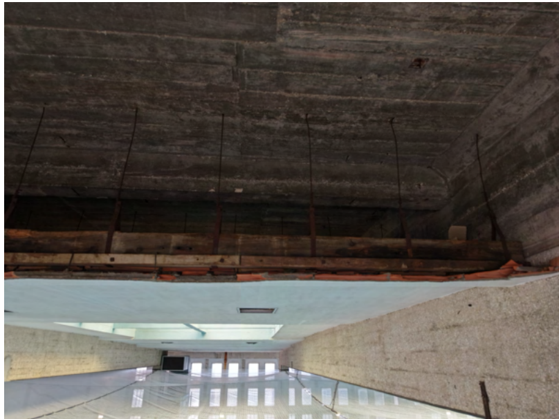
Aperçu de la constitution du faux-plafond suspendu à la toiture en béton
