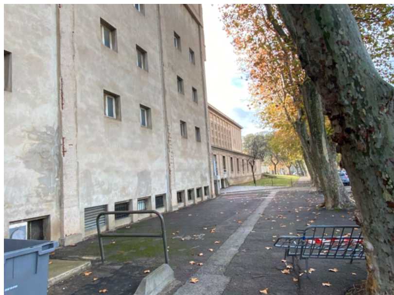
Aile Ouest depuis la façade Nord
