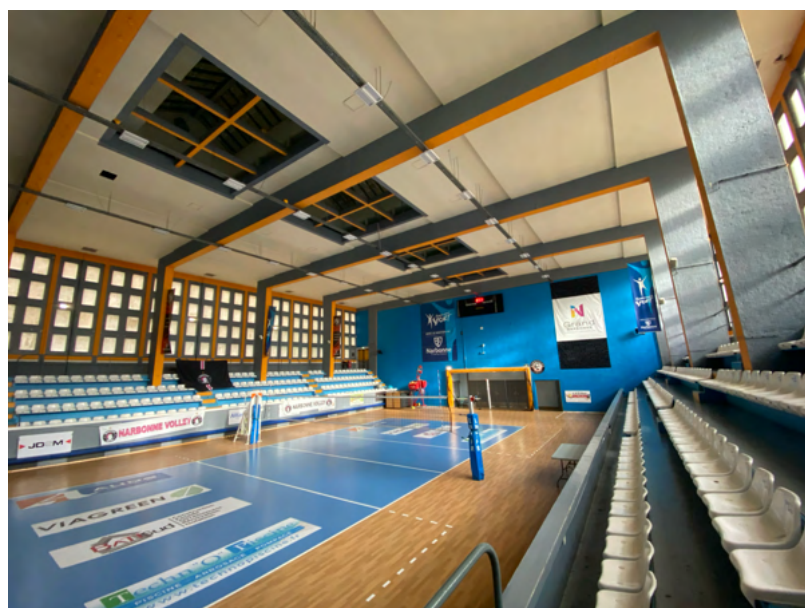
Vue d'ensemble du gymnase au sein de l'aile Est
