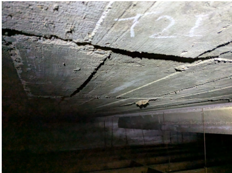
Autre vue du Plenum du gymnase : bon état général de la structure
