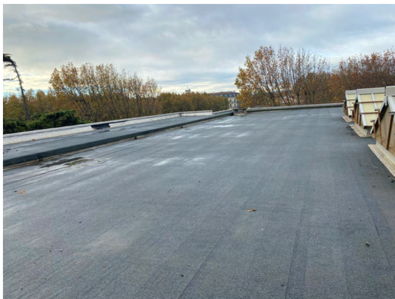
Étanchéité autoprotégée sur la toiture de l'aile Ouest
