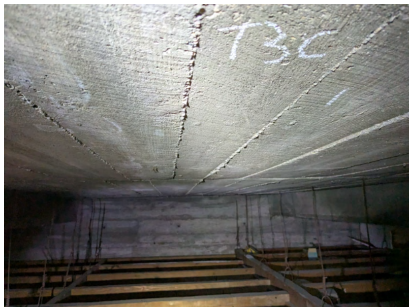
Vue du Plenum du gymnase : bon état général de la structure
