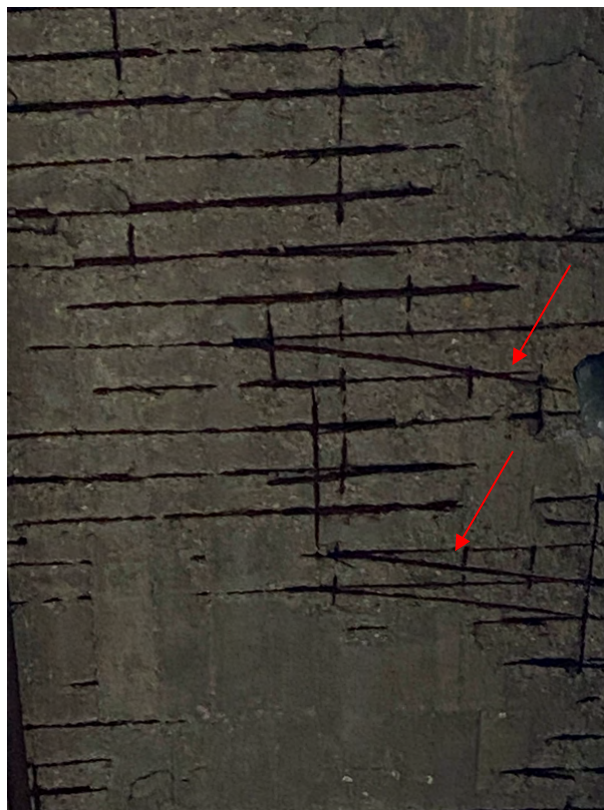
Aperçu de suspentes directement reliées aux aciers de la dalle en béton
