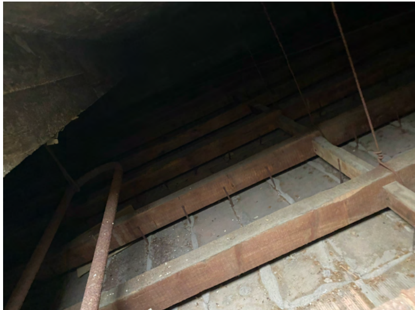
Ossature bois liée aux joints des briquettes, et suspendue à la dalle en béton
