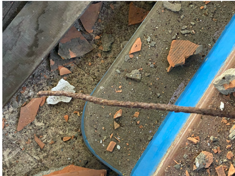
Oxydation et perte de section de l'acier des suspentes principales
