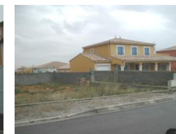
Habitat pavillonnaire banalisé
