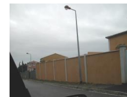
Les clôtures emmurées
