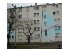
Barre d'immeuble (Rue Flemming)
