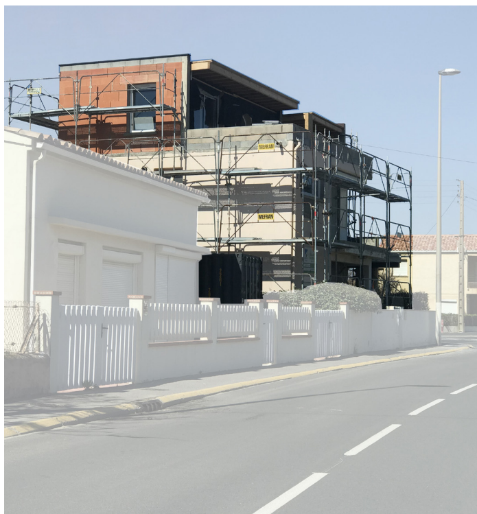
1 → 2. Extensions en cours de chantier ou réalisées
