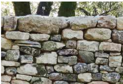
Muret pierres sèches à double parement
