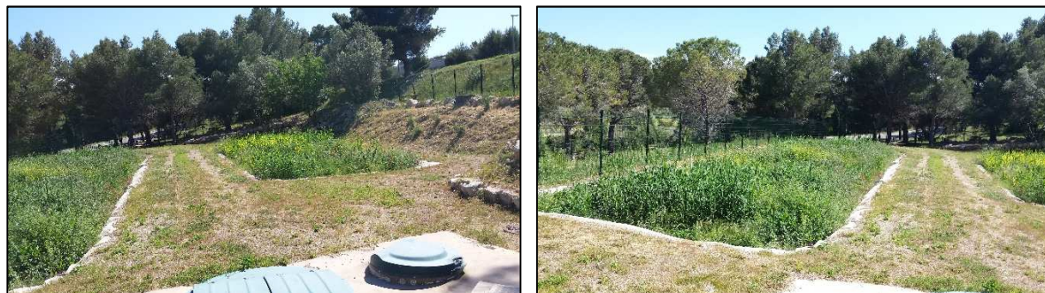
Figure 23 : Photographies d'une filière filtres plantés de roseaux après quelques mois de mise en service
