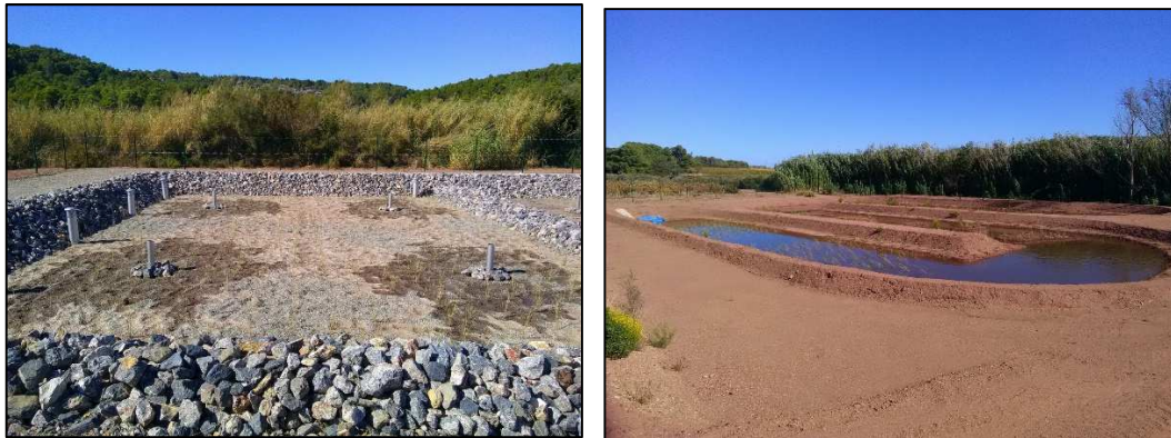
Figure 22 : Photographies d'une filière filtres plantés de roseaux et d'une zone de rejet végétalisée à leur mise en service
