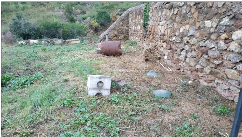
Figure 5 : Photographie de l'emplacement du système de traitement
