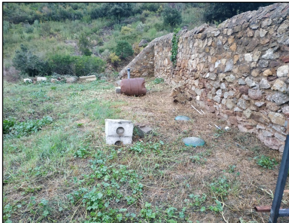
Localisation des tranchées d'épandage du système d'assainissement 1
