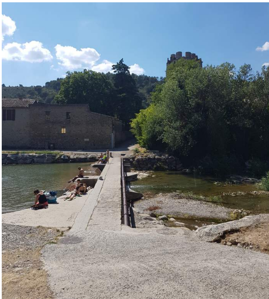
Mettre en valeur un accès existant à l'abbaye depuis la rivière à Lagrasse
