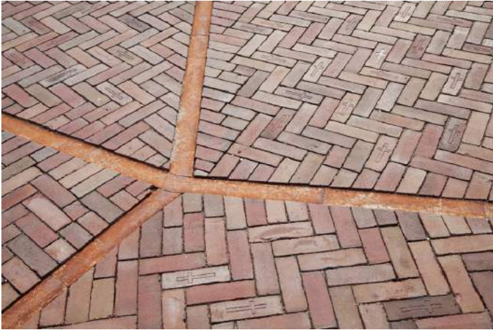
Intégration d'un fil métallique dans un pavement continu St Plechelmus Square, Oldenzaal, Pays-Bas | Bureau B+B
