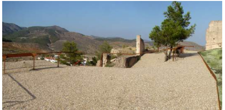
Un sol en pierre locale concassée Castillo de Oria, Almeria, Espagne | mn arquitectos
