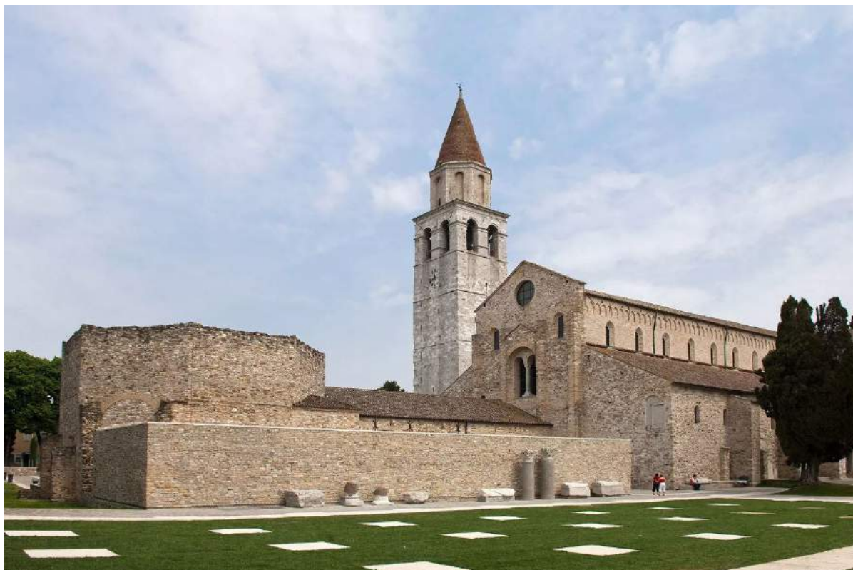
Un bâtiment d'accueil discret qui se fond dans la minéralité de la Basilique Basilique d'Aquilée, Italie
