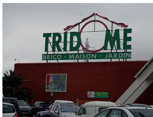
Enseigne en toiture
