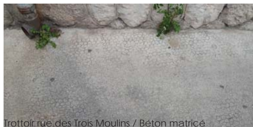
Trottoir rue des Trois Moulins / Béton matricé
