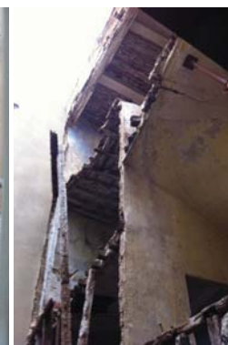
A gauche, au 7 rue Cabirol (111-AC78) - façades sur cour, en pan-de-bois, effondrées et ouvertes à toutes intempéries. A droite, au 11 rue de la Parerie (114-AB170) - façade sur cour, en pan-de-bois, effondrée.
