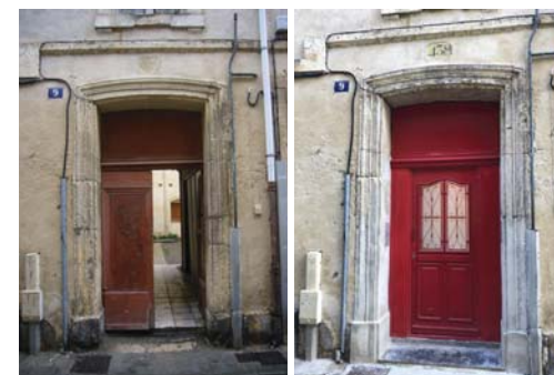
11 rue Hoche (131-AB565). A gauche, avant travaux. A droite, après travaux. Ne subsiste que l'imposte, les deux vantaux en bois peint ont été remplacés par une porte en pvc.
