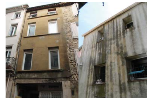
A gauche, au 20 rue Voltaire (91-AB117) - enduit ciment A droite, au 5 rue de Belfort (130-AC208) - idem
