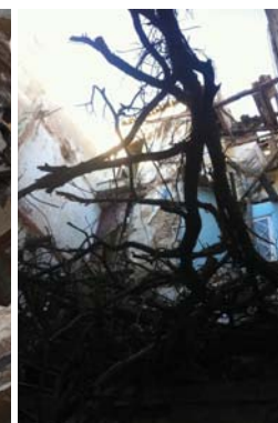
A gauche, au 6 rue du Capitole (22-AE103), planchers effondrés. A droite, au 8 impasse Ponsard (67-AD305), planchers effondrés et élévations sur cour effondrées.
