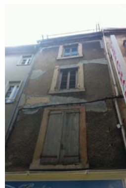
A gauche, au 9 rue Droite (45-AE183) - façade en pan-de-bois enduit au ciment. A droite, au 5 rue Faubert (22-AE106) - façade en pan-de-bois en très mauvais état.
