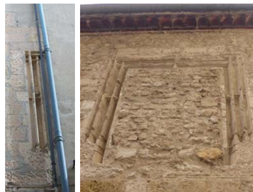
Encadrement orné d'une moulure croisée d'une croisée au 8 rue Louis Blanc (67-AD293), avec archivolte rectangulaire filante bûchée, et du 28 rue Auber (62-AD567).
