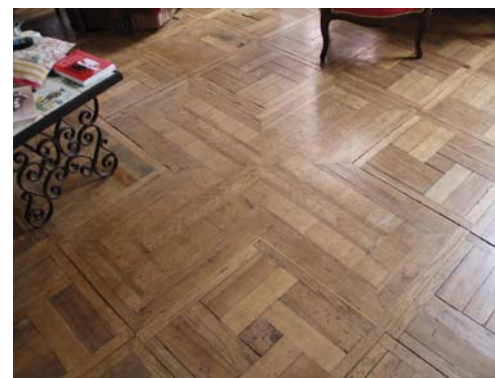
Parquet à compartiments : 7 place des Jacobins (110-AC386).
