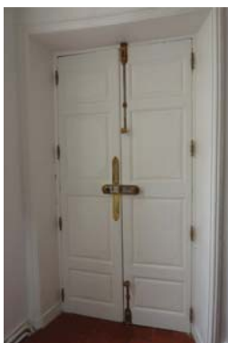
Portes XVIII e avec quatre panneaux par vantail ; à gauche au 17 rue Rouget de l'Isle (22-AE107) ; à droite au 6 quai Dillon (83-AB475).
