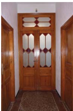
Portes vitrées du XIX e siècle avec carreaux en verre coloré, à relief ou avec vitrauphanie, enchâssés dans des petits bois ; à gauche au 7 rue du Lieutenant-Colonel Deymes (22-AE95), à droite au 9 boulevard Gambetta (72-AD346).
