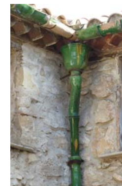
Gouttière et descente en terre cuite vernissée, au 9 rue Kléber (95-AB138), et gouttière sur rue au 6 bis rue Voltaire (85-AB58).
