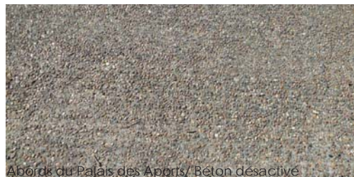
Abords du Palais des Apports/ Béton désactivé
