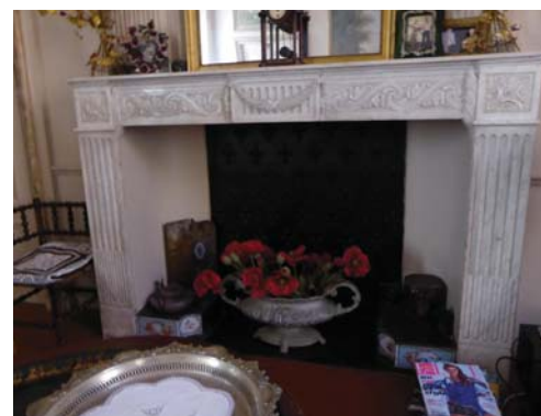
Manteau de cheminée néoclassique du XVIIIe siècle avec piédroits cannelés, roses et guirlandes, au 16 quai Dillon (81-AB39). A noter le foyer parabolique à la Gauger, et la tache fleur-de-lysée.
