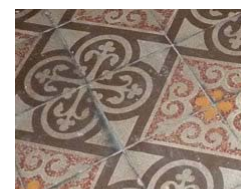
Sol avec carreaux hexagonaux et losanges carrés au 12 rue Charras (55-AD235).
