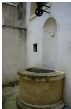
Puits à mur de margelle droit, 4bis rue Armand Gauthier (46-AE164) et 8 rue du Luxembourg (133-AC21).
