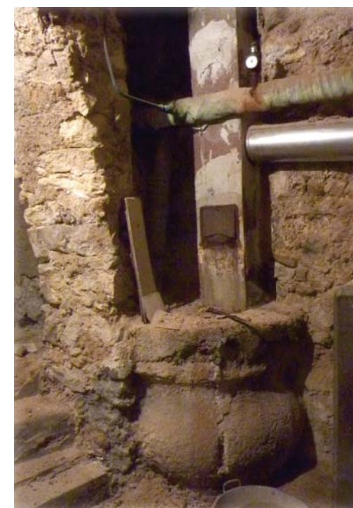
Puits en cave, margelle en vasque, 4 rue Rouget de l'Isle (46-AE168).
