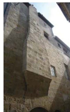
Souche en encorbellement du 5 place Cassagnol (133-AC28).
