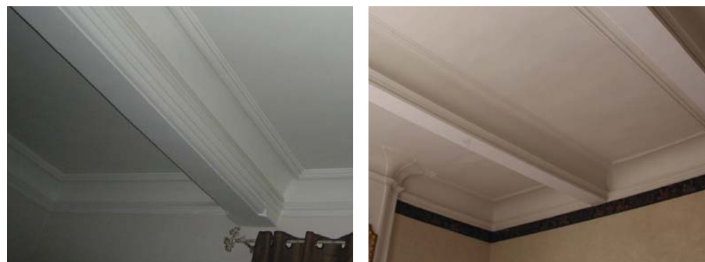
Plafond lambrissé et plâtré avec corniche à gorge et poutres apparentes, avec moulure à l'arête de la poutre révélant la très probable présence d'un ancien plafond médiéval, au 6 rue Viollet-le-Duc (64-AD80).
