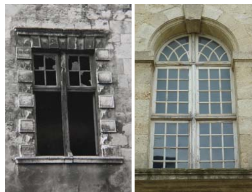
A gauche, une ancienne fenêtre du 16 rue Parmentier, (photo MP 81/11/33) avec meneau et traverse en bois. A droite, fenêtre sur cour de La Charité (84-AB50).
