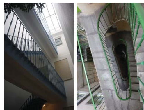
Escaliers à passerelle ou volée indépendante : à gauche, au 25 rue du Pont des Marchands (78-AC116) ; à droite, au 14 rue Cabriol (128-AC62).
