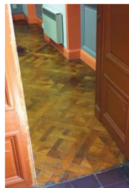
Parquets à compartiments : à gauche au 10 quai Dillon (83-AB48) ; à droite, au 9 rue des Jacobins (100-AC144).
