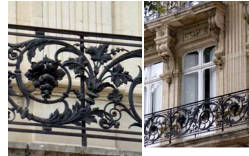
Garde-corps en fonte moulée du 34 boulevard Marcel Sembat (18-A1812).
