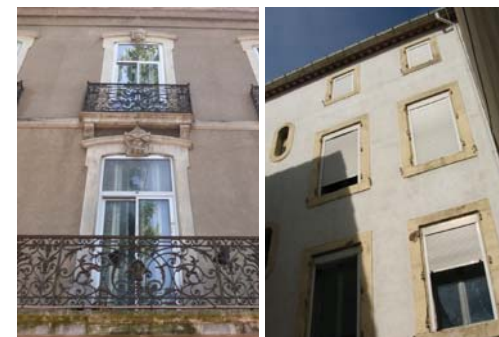
A gauche, au 15 boulevard Marcel Sembat (19-AE33) - double fenêtre extérieure en pvc, posée devant les contrevents. A droite, au 15 avenue des Pyrénées (88-AW255) - volets roulants pvc en remplacement des contrevents.
