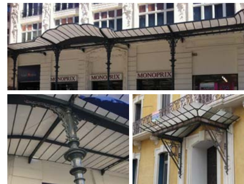
Marquises ; en haut et en bas à gauche aux Dames de France (77-AD1/7), sur poteaux en fonte, en bas à droite au 1 qui de l'Escoute (85-AB54).
