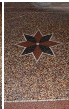
Sol en terrazzo avec motif étoilé au 1bis rue de l'Ancienne Porte de Béziers (14-AH78).
