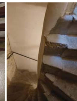
A gauche, au 5 rue des Trois Moulins (12-AH19) - escalier en vis en béton.
