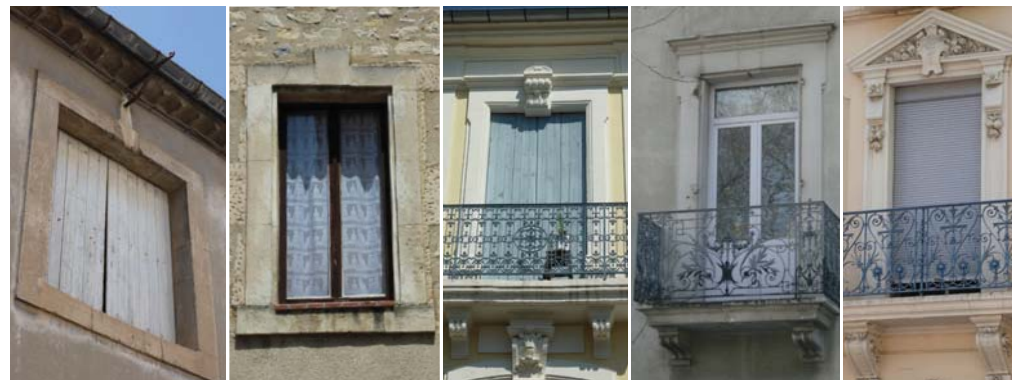
Fenêtres à plate-bande : simple encadrement en ressaut au 27 rue de l'Ancienne Porte Neuve (37-AE16), simple clef au 4 rue de Blida (3-AI548), encadrement à crossette et clef en agrafe, au 3 boulevard Marcel Sembat (3-AI544), corniche au 2 avenue Emile Sermet (15-AI526), et fronton triangulaire au 38 boulevard Frédéric Mistral (37-AE272).
