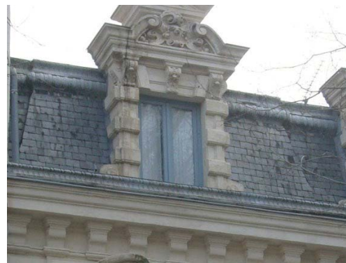
Brisis du 28 boulevard Gambetta (58-AR131), avec cordon mouluré sous membran et chéneau en zinc à façade décorée.
