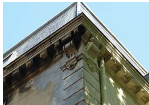
De gauche à droite et de haut en bas. Corniche simplement moulurée au 3 boulevard Marcel Sembat (3-AI544), avec denticules au 30 boulevard Marcel Sembat (10-AI569), avec modillons au 18 place Thérèse et Léon Blum (4-AI551), avec consoles au 25 rue Gustave Fabre (44-AE218).
