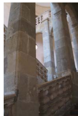
Escalier à jour à noyaux, à gauche du Palais des Archevêques (45-AE187) ; à droite, dans l'ancien couvent des Carmélites, au 7 rue Michelet (26-AH321).
