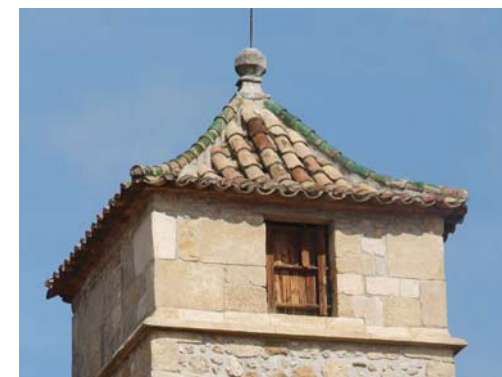
Arêtières du clocher de l'ancienne église du couvent des Carmes, en tuiles vernissées (85-AB666).
