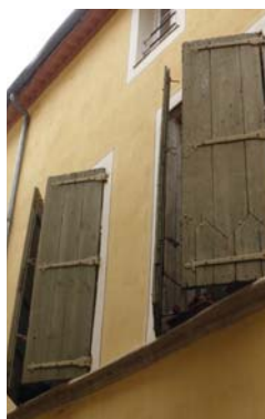
A gauche, contrevents plein avec penture à têtes refendues et enroulements rentrants au 7 rue Francis Marcéro (27-AH104). A droite, contrevents avec pentures à têtes fleur-de-lysées au 5 rue Louis Blanc (66-AD26).
