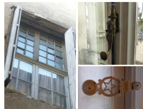
A gauche, menuiserie de transition entre petits et grands carreaux au 7 rue Louis Blanc (64-AD76). A droite, deux poignées différentes au 15 cours de la République (76-AD503), en haut sur la rue (poignée XIX e ), en bas sur la cours.
