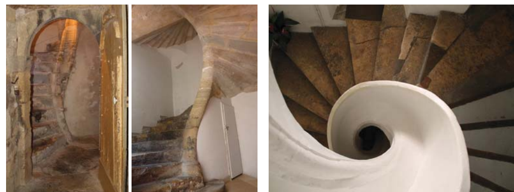
Escalier en vis en pierre à noyau creux, à gauche au 7 rue de la Monnaie (111-AC388) ; à droite au 5 rue Marceau (128-AC57).
