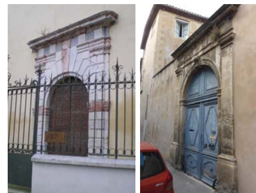
Portes à arc en plein cintre, pilastres et entablement, à gauche sur la chapelle de l'Hôpital Saint-Paul (135-A726), et à droite au 4 rue Auber (63-AD284).
