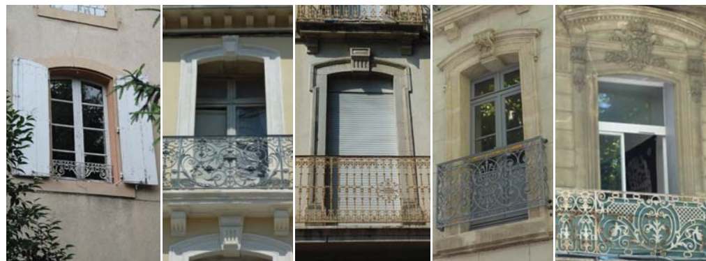
Fenêtres à arc surbaissé : simple encadrement en ressaut légèrement saillant au 45 rue de l'Ancienne Porte Neuve (19-AE27), encadrement plus travaillé et clef au 6 rue de Blida (3-AI547), encadrement à crossettes au 32 avenue Pierre Sémard (3-AI537), clef en agrafe et corniche cintrée au 7 avenue Marcel Sembat (19-AE36), décoration finement travaillée (corniche à denticules, mascarons, consoles) au 18 boulevard Frédéric Mistral (37-AE267).
