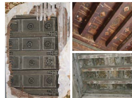
A gauche, plafond du 3-5 rue Charras (50-AD139), avec roses sur les merrains et motifs réalisés par pochoirs ; à droite en haut, plafond de l'hôtel de la Précenterie (36-AE78), avec pierres précieuses réalisées en papier mâché ; en bas, plafond avec fleurs sur les merrains et pierres précieuses sur les closoirs, au 5 rue Rouget de l'Isle (36-AE275).
