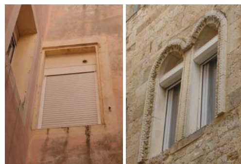
A gauche, au 9 rue de l'Ancienne Porte de Béziers (14-AH74) - fenêtre surbaissée, volet roulant en pvc. A droite, au 1bis rue Rouget de l'Isle (76-AE74) - dans une baie romane, menuiseries et volets roulants en pvc.
