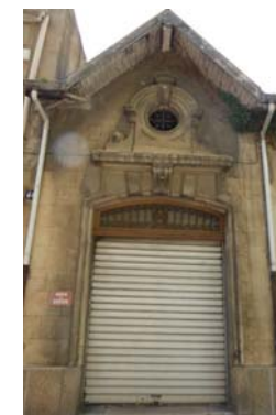
Porte de garage, à arc surbaissé, au 40 boulevard Marcel Sembat (18-AI3), et porte rectangulaire à linteau (outre bois ou profilé métallique) au 4 rue du 14 Juillet (150-AT91).
