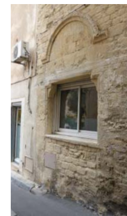
Porte médiévale à linteau droit sur coussinets, au 1bis rue Rouget de l'Isle (36-AE74), et angle de rue à profil torique au 75 rue Droite (24-AE131).
