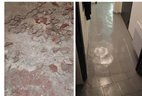
A gauche, au 7 rue Marceau (128-AC56) - sol en carreaux de terre cuite, en cours de démolition. A droite, au 2 impasse Rameau (73-AD380) - carreaux de terre cuite peints.
