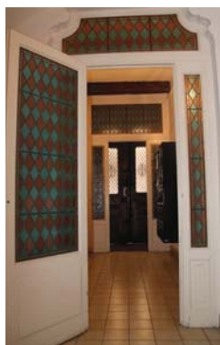
Portes vitrées du XIX e siècle avec vitraux en réseau de plomb ; à gauche au 23 rue Voltaire (94-AB106) ; à droite au 6 rue de la Parerie (112-AB617).
