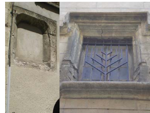
Petite baie à arc déprimé du 29bis rue d'Aigues-Vives (116-AB330), et petite baie de la tourelle d'escalier de l'hôtel de l'Aumône au 67 rue Droite (35-AE142), avec congé sculpté, appui et archivolte rectangulaire.
