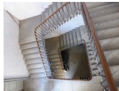
Large escalier suspendu à marche sur marche sans limon, en pierre d'Armissan, au 4 rue Auber (63-AD284).
