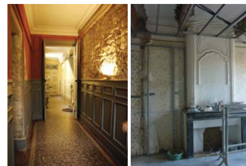
A gauche, sur une paroi de l'entrée du 8 rue Hippolyte Faure (81-AB39) - au-dessus du lambris, enduit plâtre pioché pour faire apparaître les moellons du mur. A droite, au 8 rue Cuvier (31-AH160) - pose de rails aux murs et au plafond.
