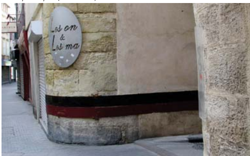
Chasse-roue sur un angle arrondi sous le coin, au carrefour des rues de l'Ancien Courrier et Louis Blanc (66-AD18).
