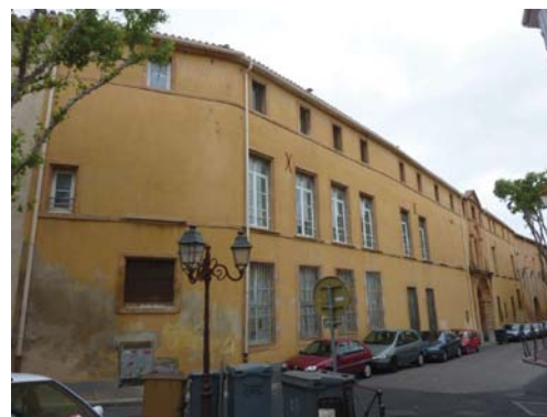
Hôtel de Saint-Félix, 16 rue Michelet (34-AH259), façade sur rue constituée de moellons enduits, encadrements, bandeaux et portail en pierres de taille.
