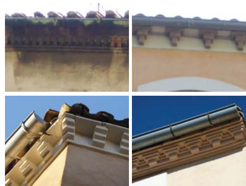
Corniches en briques imitant des modillons. De gauche à droite et de haut en bas : 48 rue du Bourget (143-AI675), 9 boulevard Marcel Sembat (19-AE35), 7 rue Viollet-le-Duc (48-AD82), 6 place du Forum (12-AH56).
