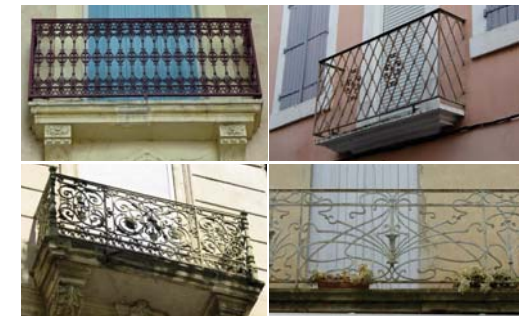
Garde-corps en fonte moulée. De gauche à droite et de haut en bas, au 19 boulevard du Docteur Ferroul (106-AT119), (73-AD401), au 54 rue Jean Jaurès (41-AE238), motifs art-nouveau au 26 boulevard du Général de Gaulle (30-AH295).
