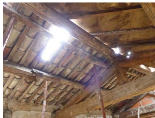
7 rue Marceau (128-AC56) - Immeuble totalement insalubre, en travaux depuis plusieurs années, couverture fuyardes, façades sans menuiseries, enduites au ciment.
