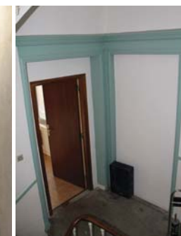
A gauche, au 12 rue Louis Blanc (63-AD285) - ajout d'une structure bois avec rampe, dans le jour de l'escalier.
