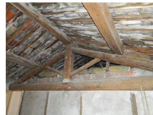
Exemple de charpente à ferme et pannes au 3 rue des Tanneurs (151-AC245).
