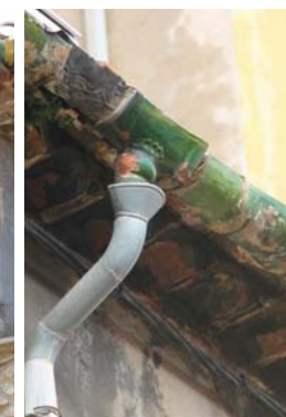
Gouttière et descente en terre cuite vernissée, au 9 rue Kléber (95-AB138), et gouttière sur rue au 6 bis rue Voltaire (85-AB58).
