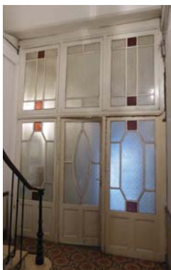
Portes vitrées du XIX e siècle avec carreaux en verre coloré, à relief ou avec vitrauphanie, enchâssés dans des petits bois ; à gauche au 7 rue du Lieutenant-Colonel Deymes (22-AE95), à droite au 9 boulevard Gambetta (72-AD346).
