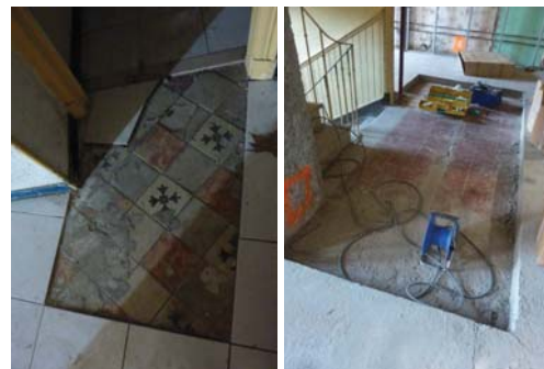
A gauche, au 38 avenue Pierre Sépard (3-AI782) - carreaux-mosaïques recouverts de grands carreaux blancs. A droite, au 8 rue Cuvier (31-AH160) - carreaux de terre cuite recouverts d'une chape ciment.
