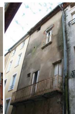
A gauche, au 7 rue Littré (60-AD269) - Immeuble partiellement insalubre, occupé mais en très mauvais état sanitaire, façade enduite au ciment. A droite, au 7 rue Auber (67-AD317) - Immeuble totalement insalubre, inoccupé.
