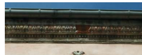
Corniches en briques posées en dents de scie. De gauche à droite et de haut en bas : 4 rue Littré (55-AD244), 4 rue Marcelin Coural (76-AD425), 12 quai Dillon (82-AB45), 2 rue Yvan Pélissier (149-AT583).
