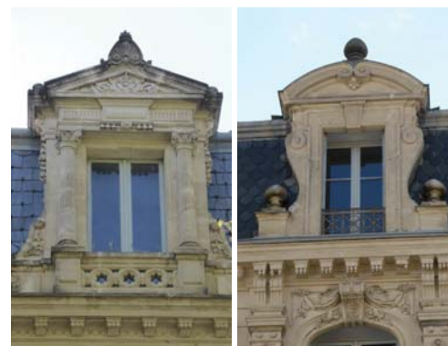
Lucarnes en pierre à fronton triangulaire au 22 boulevard Frédéric Mistral (37-AE12), à fronton cintré au 10 rue du 1er mai (42-AE224).
