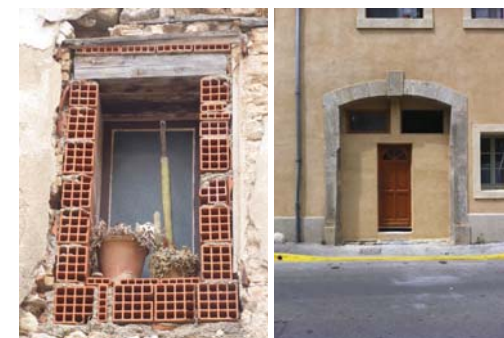
A gauche, au 8 rue de l'Aoubret (69-AD332) - baie réduite en briques creuses non enduites.
