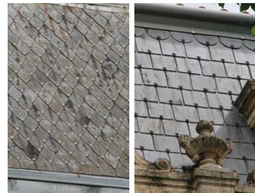
Brisis couverts en ardoises posées au crochet étoilé : à gauche, virole en forme d'étoile, au 2 rue des Thermes (10-AI662) ; à droite, crochet façonné en forme d'étoile, au 22 boulevard Frédéric Mistral (37-AE12).
