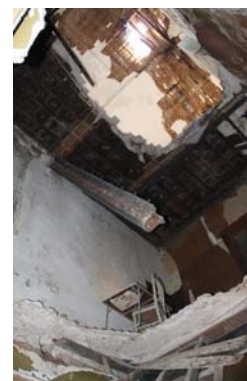
A gauche, au 6 rue du Capitole (22-AE103), planchers effondrés. A droite, au 8 impasse Ponsard (67-AD305), planchers effondrés et élévations sur cour effondrées.
