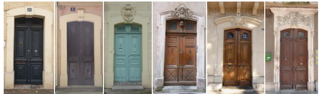
Portes d'entrée à arc surbaissé. De gauche à droite : 40 rue du Bourget (142-AT343), porte à encadrement simple en ressaut et clef légèrement saillante et pendante ; 6 boulevard du Général de Gaulle (14-AH86), clef en agrafe ; 14 boulevard du Général de Gaulle (17-AH94), décoration avec blason et chiffre en clef ; 12 rue Henri et Charles Cros (73-AD375), profil de l'encadrement affiné et mascaron sculpté en clef ; 27 boulevard Marcel Sembat (19-AE25), corniche cintrée au-dessus de l'arc ; enfin, 15 boulevard Marcel Sembat (19-AE33), décor végétal en bas-relief entre extrados de l'arc et corniche horizontale.
