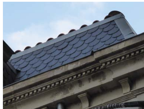
Brisis avec des ardoises en écailles au 11 boulevard du Docteur Ferroul (105-AT139).
