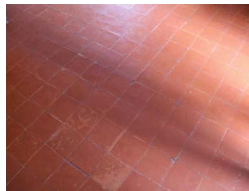
Carreaux de terre cuite en pose droite au 7 place des Jacobins (110-AC386).
