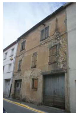
A gauche, au 22 rue de l'Ancienne Porte Neuve (20-AE247) - immeuble totalement insalubre, façade présentant d'importantes lacunes d'enduit des menuiseries extérieures en mauvais état, de gouttières fuyardes, des intérieurs inhabitables. A droite, au 33 rue Francis Marcéro (56-AD248) - immeuble totalement insalubre, façade en très mauvais état.
