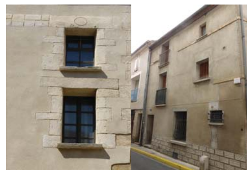
A gauche, au 27 rue de l'Hôtel-Dieu (134-AB259) - enduit à décor de faux-appareil de pierres. A droite, au 2 rue Brissot (60-AD267) - baies modifiées, enduit ciment, soubassement en faux-appareil de pierres.
