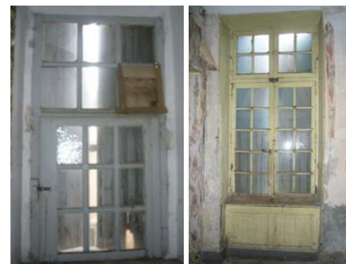
A gauche, menuiserie à petits carreaux et dés au 5 rue Charras (50-AD139). A la même adresse, menuiseries à petits bois sans dés, coffrage lambrissé en allège.
