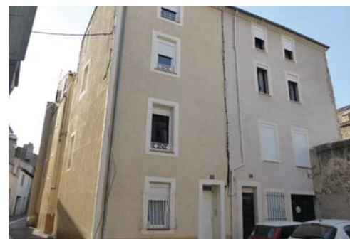
Aux 15 et 17 rue Denfert-Rochereau (132-AC239/240) - division verticale d'un immeuble ayant conduit à des teintes différentes d'enduit.
