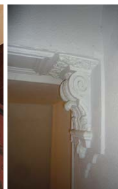
Consoles en volute supportant une poutre dans un hall d'entrée : à gauche au (12 rue Benjamin Crémieux 111-AC86) ; à droite au 8 place Voltaire (118-AB369).
