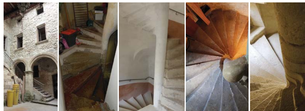
Escalier en vis à noyau plein en pierre : à gauche, 14bis rue Lamourguier (130-AC188) ; à droite, 3 rue Niquet (76-AD501).
