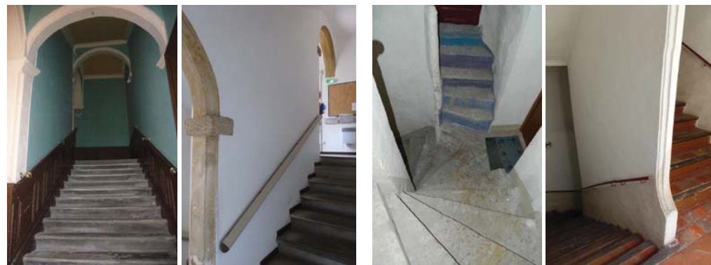
Escalier à retour à mur d'échiffre plein, à gauche au 10 rue Viollet-le-Duc (64-AD78); à droite au 1 rue de l'Etoile (82-AB45).
