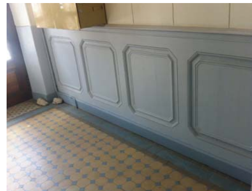
Lambris avec cimaise filante à hauteur d'appui dans un hall d'entrée de la fin du XIX e siècle, au 31 cours de la République (75-AD366)
