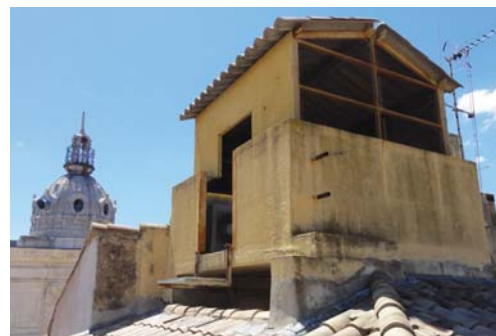
5 rue de l'Ancien Courrier (64-AD43) - édicule en béton et parpaings
