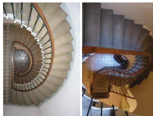
Escaliers à jour suspendu marche sur marche sans limon en pierre d'Armissan : à gauche, escalier du 9 rue du Pont des Marchands (78-AC124) ; à droite, escalier du 21 boulevard du Docteur Ferroul (106-AT118).
