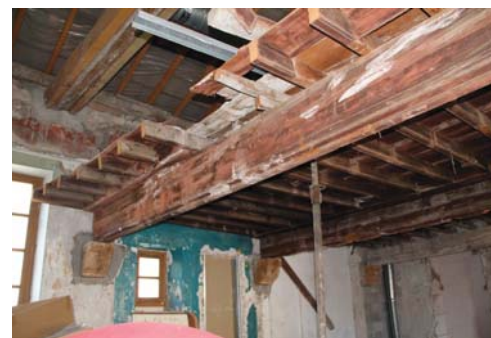
3 rue Rouget de l'Isle, dans l'ancien hôtel de la Précenterie (36-AE78) - plancher construit sous un plafond à la française.
