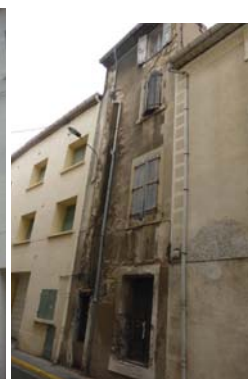
A gauche, au 22 rue de l'Ancienne Porte Neuve (20-AE247) - immeuble totalement insalubre, façade présentant d'importantes lacunes d'enduit des menuiseries extérieures en mauvais état, de gouttières fuyardes, des intérieurs inhabitables. A droite, au 33 rue Francis Marcéro (56-AD248) - immeuble totalement insalubre, façade en très mauvais état.
