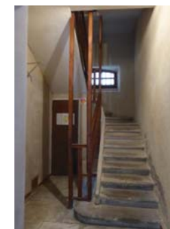
A gauche, au 12 rue Louis Blanc (63-AD285) - ajout d'une structure bois avec rampe, dans le jour de l'escalier.
