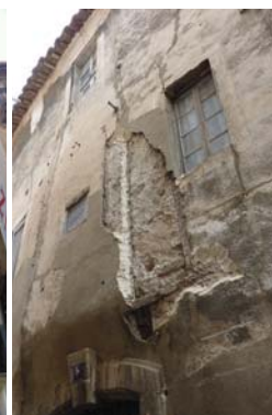
A gauche, au 9 rue Droite (45-AE183) - façade en pan-de-bois enduit au ciment. A droite, au 5 rue Faubert (22-AE106) - façade en pan-de-bois en très mauvais état.
