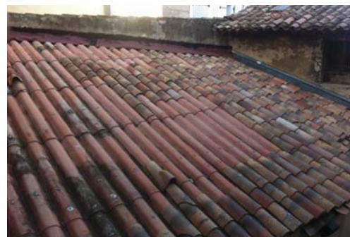
Au 75 rue Droite (24-AE131) - couverture en tôle et tuiles de couvert.
