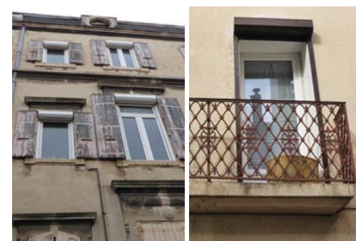
A gauche, au 4 rue de l'Ancien Port des Catalans (72-AD353) - coffres de volets roulants (en pvc) saillants, empêchant la fermeture des contrevents. A droite, au 6 rue du 14 Juillet (150-A190) - coffre de volet roulant en pvc disposé sur le nu extérieur.
