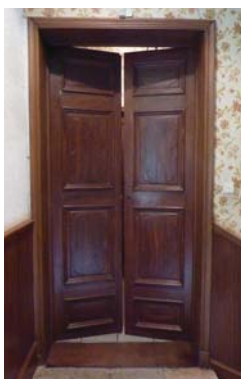
Portes XVIII e avec quatre panneaux par vantail ; à gauche au 17 rue Rouget de l'Isle (22-AE107) ; à droite au 6 quai Dillon (83-AB475).
