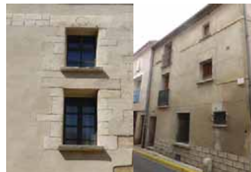
A gauche, au 27 rue de l'Hôtel-Dieu (134-AB259) - enduit à décor de faux-appareil de pierres. A droite, au 2 rue Brissot (60-AD267) - baies modifiées, enduit ciment, soubassement en faux-appareil de pierres.
