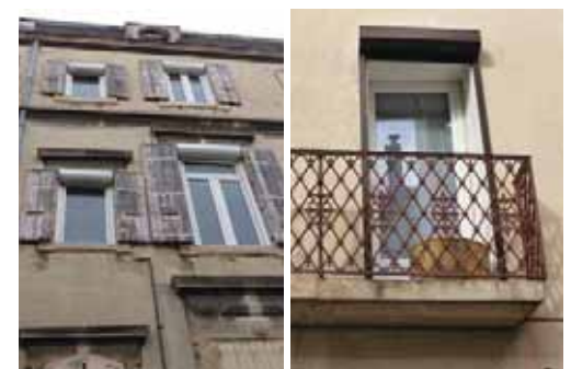
A gauche, au 4 rue de l'Ancien Port des Catalans (72-AD353) - coffres de volets roulants (en pvc) saillants, empêchant la fermeture des contrevents. A droite, au 6 rue du 14 Juillet (150-AT90) - coffre de volet roulant en pvc disposé sur le nu extérieur.
