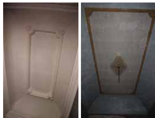
Plafonds en voussure : à gauche dans l'escalier de l'hôtel du 6 rue Ingres (114-AB169), à droite dans l'hôtel Pech de Laclauze au 1 place de Verdun (68-AD325).
