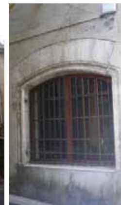
Baies commerciales et cochères en rez-de-chaussée à arc surbaissé et profil torique, au 1 rue Edgard Quinet (133-AC28) et au 75 rue Droite (24-AE131).
