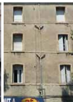
40 avenue Pierre Sémard (3-AI782) - descentes d'eaux usées se raccordant aux eaux pluviales. A gauche, raccords individuels récents. A droite, raccords collectifs relativement anciens
