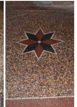
Sol en terrazzo avec motif étoilé au 1bis rue de l'Ancienne Porte de Béziers (14-AH78).
