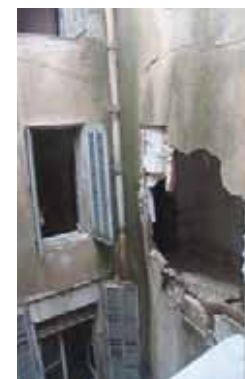
A gauche, au 7 rue Cabirol (111-AC78) - façades sur cour, en pan-de-bois, effondrées et ouvertes à toutes intempéries. A droite, au 11 rue de la Parerie (114-AB170) - façade sur cour, en pan-de-bois, effondrée.
