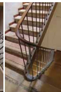
A gauche, escalier à limon porteur en pierre au 14 rue Charles et Henri Cros (73-AD396) ; à droite, escalier à limon porteur en bois de la fin du XIX e siècle au 19 cours de la République (76-AD420).
