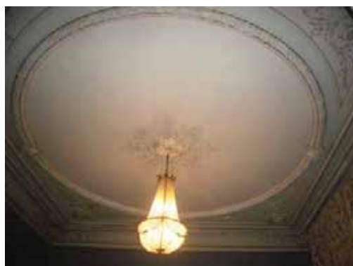
Riche plafond en plâtre et staff avec couronne, rosace centrale, et motifs dans les écoinçons du plafond et des voussures, au 10 rue Viollet-le-Duc (64-AD78).
