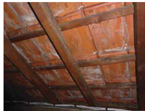
Couverture en tuiles mécaniques : tuiles à emboîtement, produit des tuileries Coudonne, au 45 rue de l'Ancienne Porte Neuve (19-AE27).
