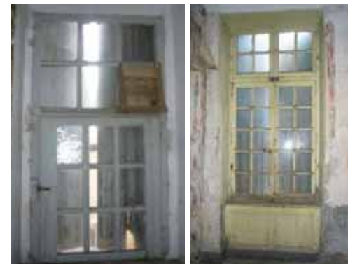
A gauche, menuiserie à petits carreaux et dés au 5 rue Charras (50-AD139). A la même adresse, menuiseries à petits bois sans dés, coffrage lambrissé en allège.
