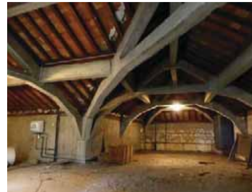
La charpente en béton armé de l'Hôtel des Postes au 40 boulevard du Général de Gaulle (59-AD257), avec sa couverture en tuiles mécaniques.
