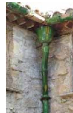
Gouttière et descente en terre cuite vernissée, au 9 rue Kléber (95-AB138), et gouttière sur rue au 6 bis rue Voltaire (85-AB58).
