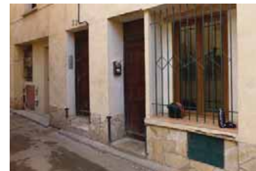
32 rue de Strasbourg (123-AB423) - soubassement revêtu de pierres minces, posées en opus incertum.
