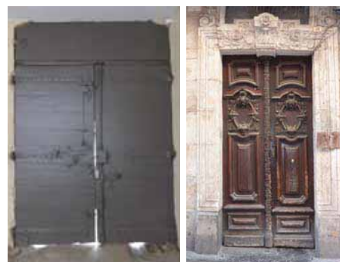
A gauche: arrière de la porte d'entrée du 2 rue Littré (56-AD250): un des systèmes de serrurerie d'origine (XVIII e ), les plus complets, observés à Narbonne. A noter : deux targelettes – haute et basse – pour sécuriser les deux vantaux entre eux, notamment la targelette haute, commandée par un verrou à renvoi ; l'espagnolette à verrou bas. A droite, porte XIX e du 45 rue Droite (46-AE158).
