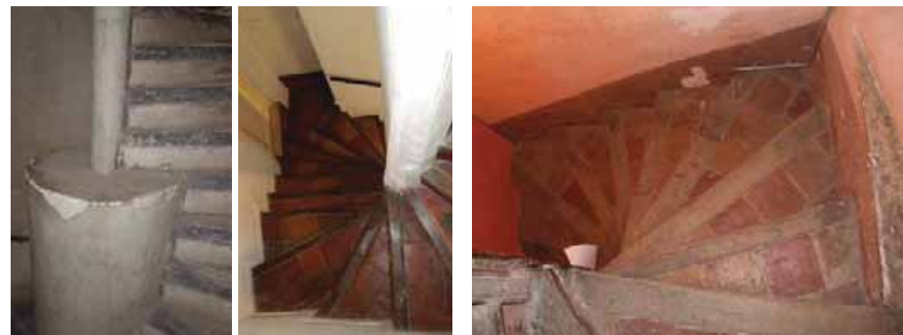
Escalier en vis à noyau plein en bois, à gauche au 75 rue Droite (24-AE131) ; à droite, au 3 rue des Tanneurs (151-AC245).
