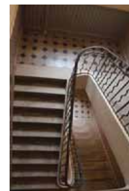
A gauche, escalier à limon porteur en pierre au 14 rue Charles et Henri Cros (73-AD396) ; à droite, escalier à limon porteur en bois de la fin du XIX e siècle au 19 cours de la République (76-AD420).
