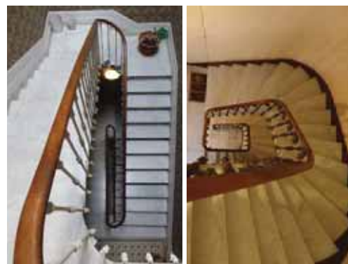
Escaliers à jour suspendu marche sur marche sans limon en marbre blanc : à gauche, escalier du 46 boulevard Frédéric Mistral (18-AI3) ; à droite, escalier du 7 rue Gustave Fabre (44-AE256).
