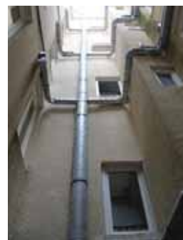
A gauche, dans la cour du 12 rue Charles et Henri Cros (73-AD375) - conduits de VMC. A droite, cour du 34 avenue Pierre Sémard (3-AI536) - descente d'eaux pluviales, conduits de fumée, climatiseur et parabole.
