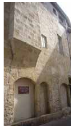
Baies commerciales et cochères en rez-de-chaussée à arc surbaissé et profil torique, au 1 rue Edgard Quinet (133-AC28) et au 75 rue Droite (24-AE131).
