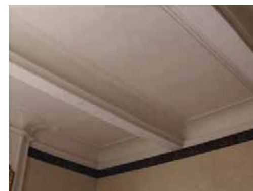
Plafond lambrissé et plâtré avec corniche à gorge et poutres apparentes, et frise peinte révélant la très probable présence d'un ancien plafond à la française peint, au 7 place des Jacobins (110-AC386).
