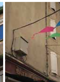
A gauche, au 11 rue Violette-le-Duc (49-AD119) - câbles d'alimentation d'un climatiseur installés en toiture, le passage se fait en contournant la gouttière en terre cuite vernissée (heureusement conservée). A droite, au 2 rue Cornaille (65-AD40) - boîtier électrique.
