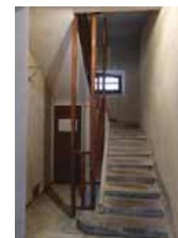
A gauche, au 12 rue Louis Blanc (63-AD285) - ajout d'une structure bois avec rampe, dans le jour de l'escalier. A droite, au 44 rue de l'Ancien Courrier (73-AD397) - portes palières murée ou réduite.
