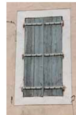
A gauche, contrevents avec planches assemblées par rainure et languette, et pentures boulonnées, sur la cour de Janotte (14-AH66). A droite, contrevents avec panneau coulissant au 15 cours de la République (76-AD503).
