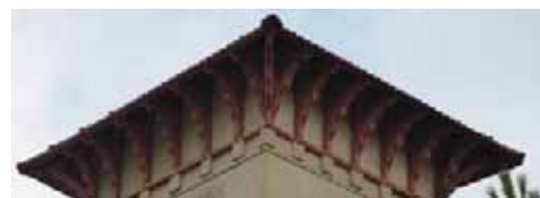
Brisis du 28 boulevard Gambetta (58-AR131), avec cordon mouluré sous membran et chéneau en zinc à façade décorée.
