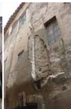
A gauche, au 9 rue Droite (45-AE183) - façade en pan-de-bois enduit au ciment. A droite, au 5 rue Faubert (22-AE106) - façade en pan-de-bois en très mauvais état.
