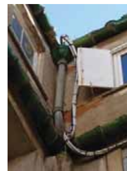
A gauche, au 11 rue Violette-le-Duc (49-AD119) - câbles d'alimentation d'un climatiseur installés en toiture, le passage se fait en contournant la gouttière en terre cuite vernissée (heureusement conservée). A droite, au 2 rue Cornaille (65-AD40) - boîtier électrique.
