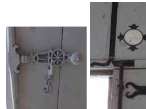
A gauche, poignée de l'espagnolette de la porte sur jardin du 4 rue Auber (63-AD284). A droite, porte du 8 rue du Capitole (22-AE104) : Exemple de deux pentures dont les têtes sont refendues à enroulement, penture verticale pour maintenir le tympan de la porte, penture horizontale pour rigidifier le vantail semi-fixe, à noter au verso du tympan la croix votive en fer repoussé cloué.
