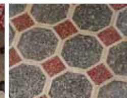
Sols avec carreaux octogonaux à cabochons, en haut en bleu et rouge, en bas avec fleurons, les deux au 13 rue Viollet-le-Duc (49-AD120).
