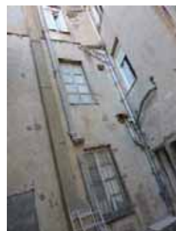
40 avenue Pierre Sémard (3-AI782) - descentes d'eaux usées se raccordant aux eaux pluviales. A gauche, raccords individuels récents. A droite, raccords collectifs relativement anciens
