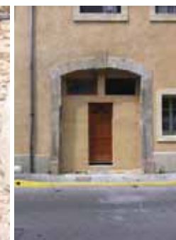
A gauche, au 8 rue de l'Aoubret (69-AD332) - baie réduite en briques creuses non enduites.
