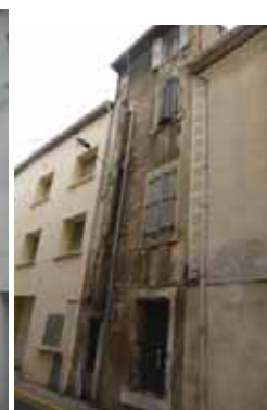
A gauche, au 22 rue de l'Ancienne Porte Neuve (20-AE247) - immeuble totalement insalubre, façade présentant d'importantes lacunes d'enduit des menuiseries extérieures en mauvais état, de gouttières fuyardes, des intérieurs inhabitables. A droite, au 33 rue Francis Marcéro (56-AD248) - immeuble totalement insalubre, façade en très mauvais état.
