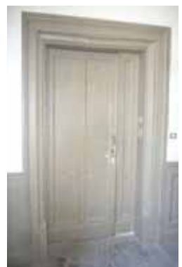
porte à cadre rapporté-clouté ; à gauche au 18 rue Louis Blanc (50-AD140), à droite dans les combles du 12 rue Charra (55-AD235).
