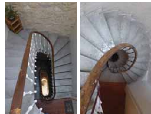
Escaliers à jour suspendu marche sur marche sans limon en pierre d'Armissan : à gauche, escalier du 11bis rue Arago (123-AB616) ; à droite, escalier du 37 boulevard du Docteur Ferroul (150-AT92).
