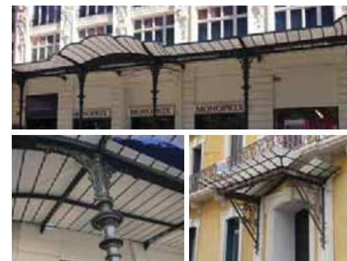
Marquises ; en haut et en bas à gauche aux Dames de France (77-AD1/7), sur poteaux en fonte, en bas à droite au 1 quai de l'Escoute (85-AB54).
