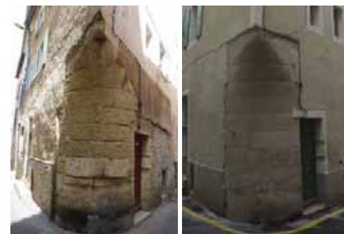
Au 5 rue Ingres (113-AC66) - angle-sous-le-coin, bel ouvrage en pierre taillée, maintenant enduit.
