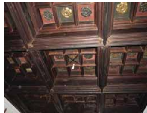
Plafond à caissons, peut-être du XVI e siècle, au 71 rue Droite (35-AE140)
