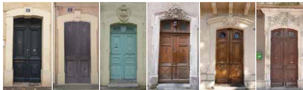
Portes d'entrée à arc surbaissé. De gauche à droite : 40 rue du Bourget (142-AT343), porte à encadrement simple en ressaut et clef légèrement saillante et pendante ; 6 boulevard du Général de Gaulle (14-AH86), clef en agrafe ; 14 boulevard du Général de Gaulle (17-AH94), décoration avec blason et chiffre en clef ; 12 rue Henri et Charles Cros (73-AD375), profil de l'encadrement affiné et mascarone sculpté en clef ; 27 boulevard Marcel Sembat (19-AE25), corniche cintrée au-dessus de l'arc ; enfin, 15 boulevard Marcel Sembat (19-AE33), décor végétal en bas-relief entre extrados de l'arc et corniche horizontale.
