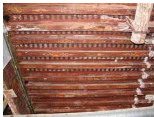
Plafond à solives espacées tant-plein-que-vidé de la première moitié du XVII e siècle, au premier étage de l'Hôtel de la Précenterie, 3 rue Rouget de l'Isle (36-AE78).
