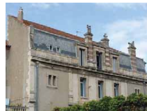
Au 40 boulevard Frédéric Mistral (37-AE24), toit brisé avec brisis en ardoise et terrasson en tuiles à emboîtement.
