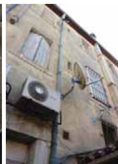
A gauche, dans la cour du 12 rue Charles et Henri Cros (73-AD375) - conduits de VMC. A droite, cour du 34 avenue Pierre Sémard (3-AI536) - descente d'eaux pluviales, conduits de fumée, climatiseur et parabole.
