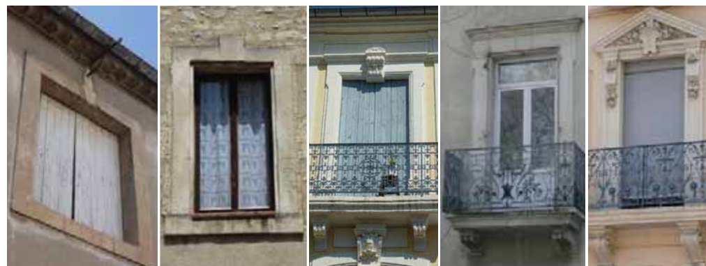
Fenêtres à plate-bande : simple encadrement en ressaut au 27 rue de l'Ancienne Porte Neuve (37-AE16), simple clef au 4 rue de Bilda (3-AI548), encadrement à crossette et clef en agrafe, au 3 boulevard Marcel Sembat (3-AI544), corniche au 2 avenue Emile Sermet (15-AI526), et fronton triangulaire au 38 boulevard Frédéric Mistral (37-AE272).
