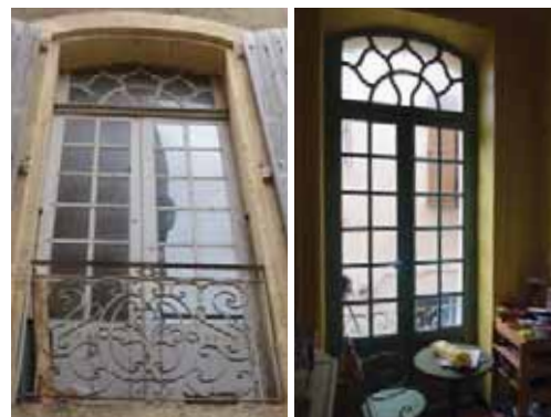
Menuiserie à petits bois avec savant dessin en imposte, face extérieure et face intérieure, au 10 rue du Général Mirabel (48-AD85).
