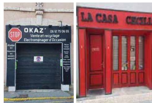
A gauche, au 2 rue Francis Marcéro (14-AH90) - encadrement mouluré en pierre, masqué par la nouvelle devanture, vitrine surbaissée à cause du coffre de volet roulant.
