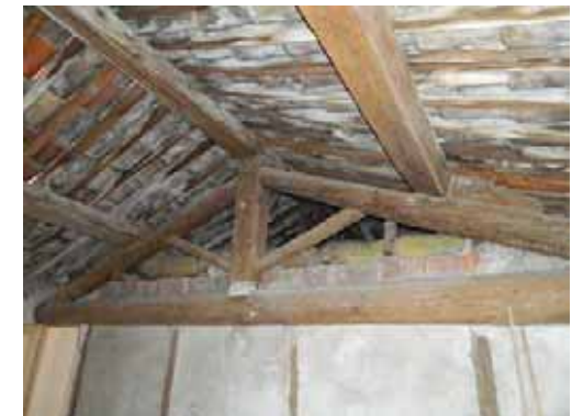
Exemple de charpente à ferme et pannes au 3 rue des Tanneurs (151-AC245).
