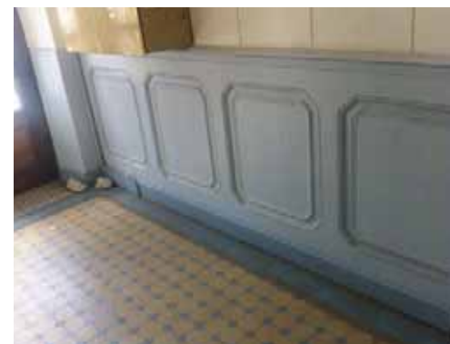
Lambris avec cimaise filante à hauteur d'appui dans un hall d'entrée de la fin du XIX e siècle, au 31 cours de la République (75-AD366).
