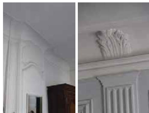
Plafonds à gorge : à gauche, raccord avec le trumeau de la cheminée du 18 rue Rouget de l'Isle (23-AE133) ; à droite, feuille d'acanthé en plâtre sculpté dans la gorge du salon du 17 rue de l'ancienne porte de Béziers (14-AH335).
