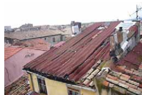
Au 2bis rue Général Mirabel (48-AD101) - couverture en tuiles canal anciennes, revêtues d'un carton bitumineux.
