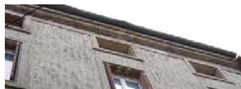
Corniche en pierre de taille avec profil en quart-de-rond et carreaux de terre cuite disposés en dents de scie au 2 rue Littré (56-AD250).
