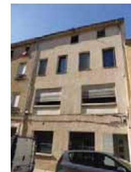
A gauche, au 24 rue Gabriel Pelouze (31-AH148) - baies élargies au rez-de-chaussée et au premier étage.
