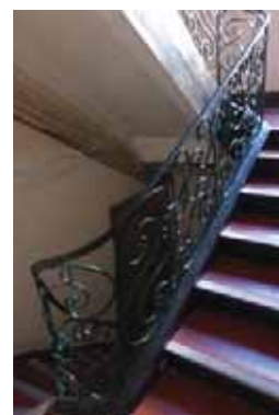
Escaliers à jour suspendu à limon porteur, à gauche en bois au 1 rue Baudin (48-AD83/84) ; à droite au 4 rue Cornelle (65-AD34).
