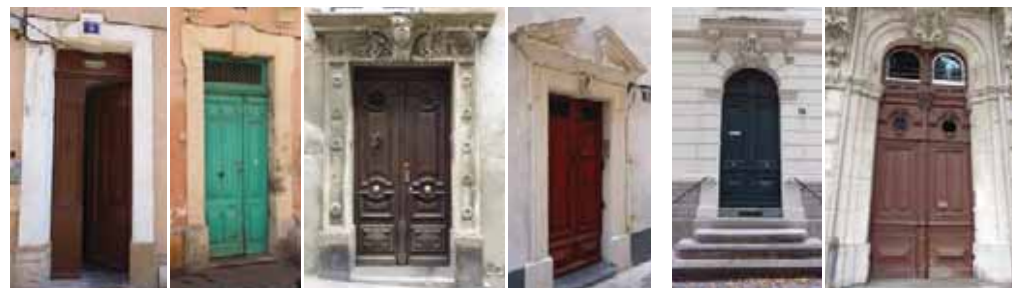
Portes d'entrée à plate-bande. De gauche à droite : 5 rue Brissot (59-AD543), porte bise à encadrement simple en ressaut et clef légèrement saillante et pendante ; 9 rue de l'ancienne Porte de Béziers (14-AH74), avec encadrement à crossette et clef plus développée ; 1 rue Voltaire (84-AB52), avec encadrement décoré, blason en clef et corniche ; 2 impasse Rameau (73-AD380), profil de l'encadrement à crossette affiné, chiffre en clef, fronton brisé.
