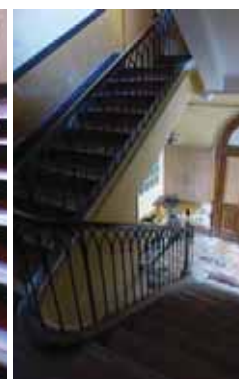
Escaliers à jour suspendu à limon porteur, à gauche en bois au 1 rue Baudin (48-AD83/84) ; à droite au 4 rue Cornelle (65-AD34).
