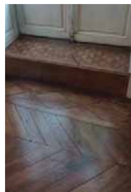
Parquets à points de Hongrie : à gauche, au 6 quai Dillon (83-AB475), avec bordure et marqueterie ; à droite, au 8 rue du 1 er Mai (42-AE225), à deux essences de bois.
