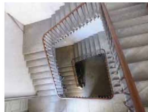
Large escalier suspendu à marche sur marche sans limon, en pierre d'Armissan, au 4 rue Auber (63-AD284).
