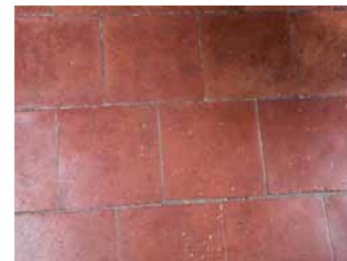
Carreaux de terre cuite posés à joints décalés au 13 rue Viollet-le-Duc (49-AD120).
