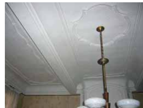
Plafond à gorges au droit des murs, de la cheminée et des poutres, au 4 rue Rouget de l'Isle (46-AE168).
