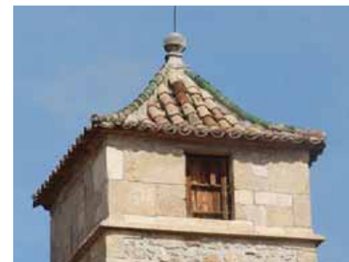
Arêtiers du clocher de l'ancienne église du couvent des Carmes, en tuiles vernissées (85-AB666).
