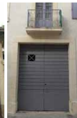
Porte de garage, à arc surbaissé, au 40 boulevard Marcel Sembat (18-AI3), et porte rectangulaire à linteau (outré bois ou profilé métallique) au 4 rue du 14 Juillet (150-AT91).
