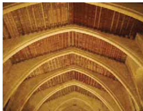
Charpente de toit sur arcs-diaphragmes à Notre-Dame-de-Lamourguier (108-AC169).
