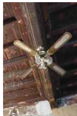
A gauche, plafond peint de la première moitié du XVII e siècle, au rez-de-chaussée de l'Hôtel de la Précenterie au 3 rue Rouget de l'Isle (36-AE78), avec planchettes au-dessus des lambourdes. A droite, coupe sur la poutre avec planchettes au 10 rue Rabelais (116-AB331) (cf. Monique Bourin, Georges Puchal, op. cit., p. 85).
