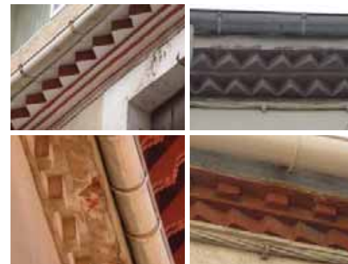
Corniches en briques posées en dents de scie. De gauche à droite et de haut en bas : 4 rue Littré (55-AD244), 4 rue Marcelin Courat (76-AD425), 12 quai Dillon (82-AB45), 2 rue Yvan Pélissier (149-AT583).
