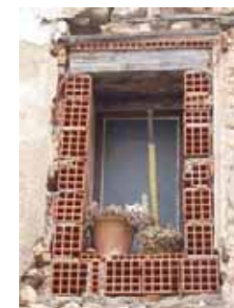
A gauche, au 8 rue de l'Aoubret (69-AD332) - baie réduite en briques creuses non enduites.
