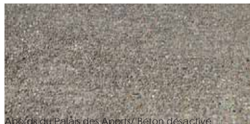
Abords du Palais des Apports/ Béton désactivé
