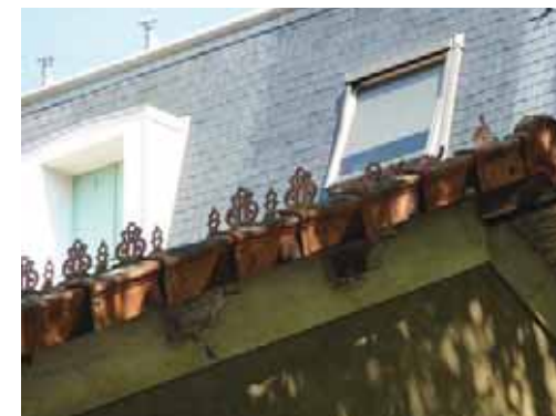
Couverture en tuiles mécaniques : tuiles de rives et tuiles faitières avec crêtes sur la dépendance du 18 place Thérèse et Léon Blum (4-AI551).
