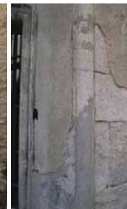
Porte médiévale à linteau droit sur coussinets, au 1bis rue Rouget de l'Isle (36-AE74), et angle de rue à profil torique au 75 rue Droite (24-AE131).
