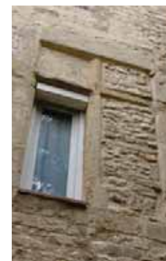
Croisée à profil chanfreiné au 1 impasse Scribe (36-AE74).
