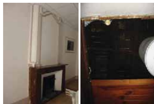
A gauche, au (44-AE214) - faux-plafond cachant la partie supérieure du trumeau de la cheminée. A droite, (116-AB329) - vide au-dessus du faux-plafond.
