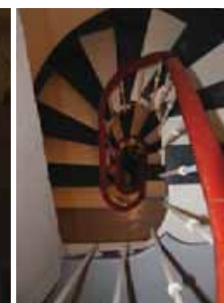
A gauche, au 4 rue Charras (55-AD240) - escalier avec marches en carreaux blancs. A droite, au 2 impasse Rameau (73-AD380) - escalier avec marches en pierre d'Armissan peinte.
