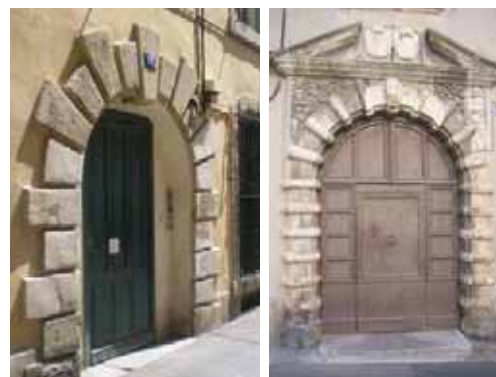
Porte en plein cintre à bossages au 16 rue Rouget de l'Isle (35-AE137), et porte du 8 rue Viollet-le-Duc (64-AD79).
