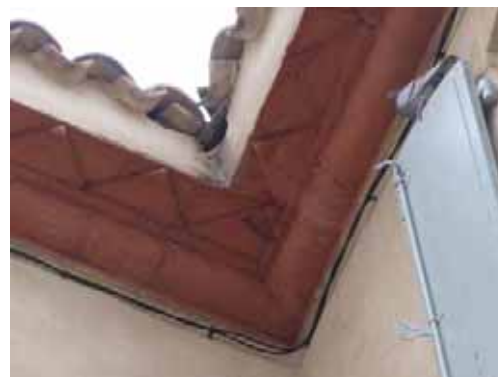
Corniche en pierre de taille avec profil en quart-de-rond et carreaux de terre cuite disposés en dents de scie au 2 rue Littré (56-AD250).
