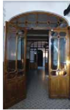
Portes vitrées du XIX e siècle avec carreaux en verre coloré et à relief, enchâssés dans des petits bois ; à gauche au 4 rue de l'Ancien Port des Catalans (72-AD353), à droite au 15 cours de la République (76-AD503).
