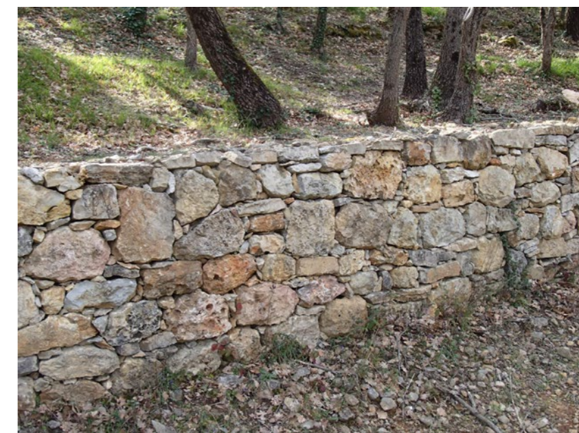
Mur en pierre (soutènement) - référence pour l'accès technique spa et la pinède littorale
