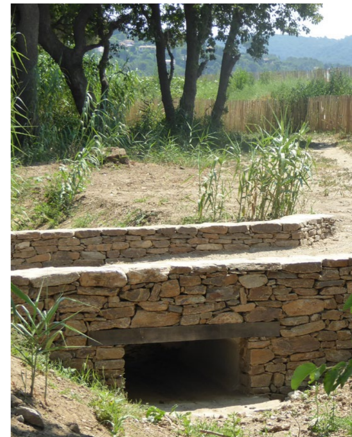
Ouvrage en parement pierre pour le franchissement du fossé existant
