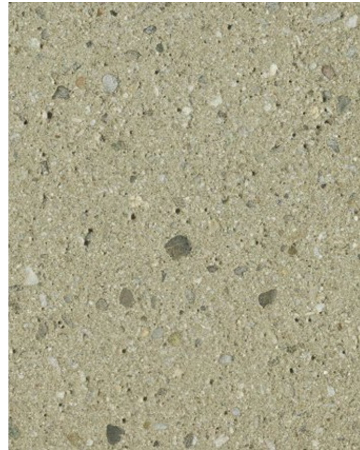
Béton de site
