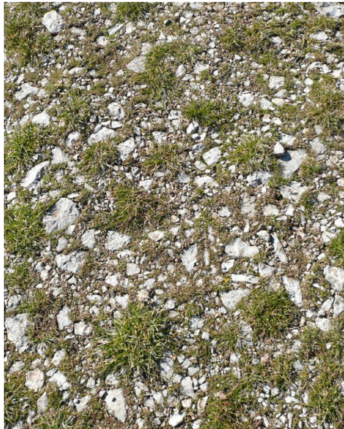
Mélange terre-pierre pour les aires de stationnement et l'allée des vignes
