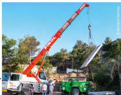
**Théâtre de la Nature** : augmentation de la capacité d'accueil du site [2 686 spectateurs] avec création d'une 3<sup>e</sup> issue de secours, pose d'un escalier et d'un portail, mise à jour de l'éclairage de sécurité, purge de la falaise et réalisation de zones « backstage ».
