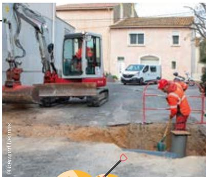
**Rue de la Robine** : requalification de la voie entre le quai de Lorraine et la rue Garancière avec la création de trottoirs et d'une bande de stationnement, l'enfouissement des réseaux aériens, l'installation d'un nouvel éclairage LED et la mise en place d'un sens unique.
