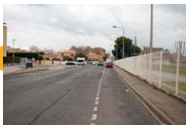
Rue St-Salvayre avant les travaux
