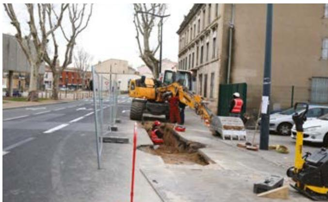
En vue de la réception du futur pôle d'échange multimodal sur le **parking Léon-Augé** : rénovation de la voirie et mise en œuvre d'un réseau pluvial.
