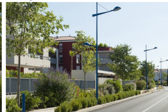
Aménagement de voirie urbaine
