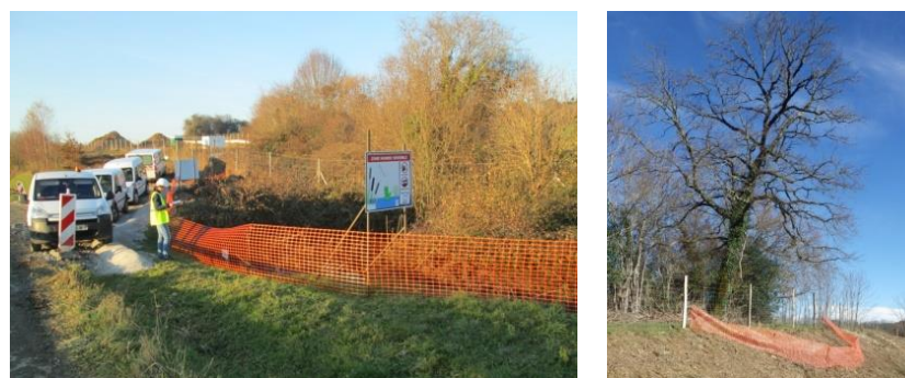
Figure 20 : Exemples de mises en défens sur un chantier
