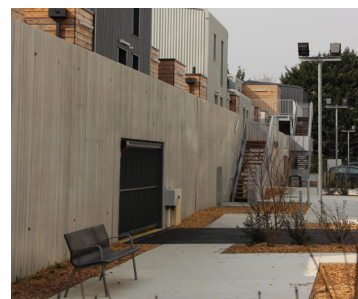
Socle béton matricé
