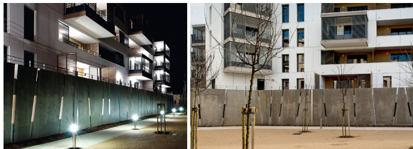
Socle béton à failles
