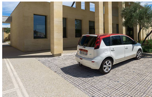
Dalles perméables graviers
