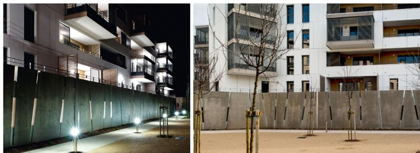
Socle béton à failles
