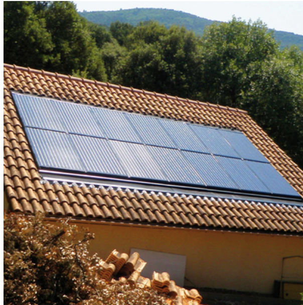
☞ Photographie 2 : Panneaux photovoltaïques intégrés en toiture
